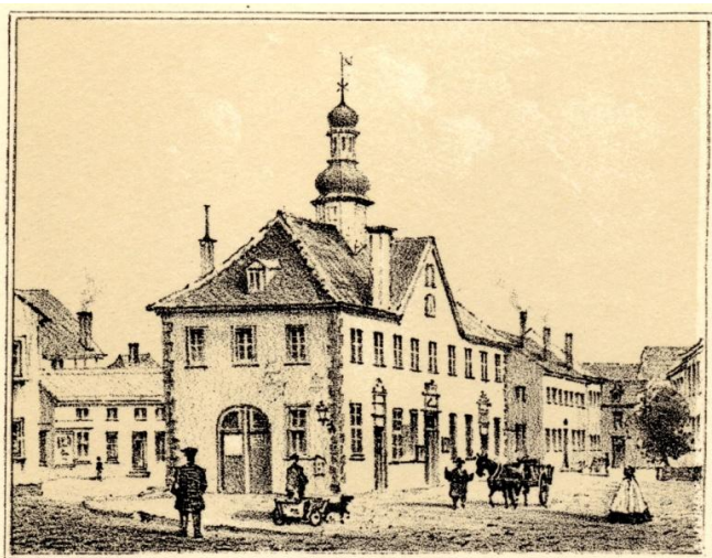
Das 1738 nach dem Stadtbrand errichtete Rathaus wurde 1875 durch den heute noch bestehenden Neurennaissancebau ersetzt. Farblithographie, vor 1872
