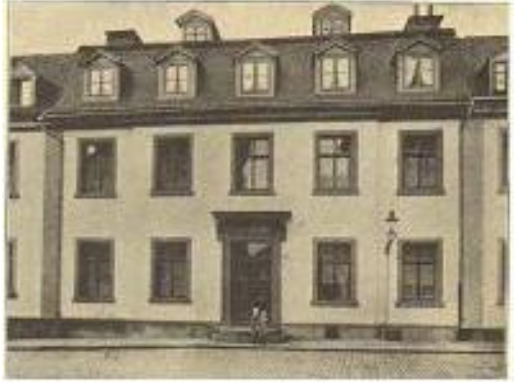
an dem Ort des vormals Megedeschen Hauses errichtetes späteres reformiertes Pfarrhaus, Ohl 7
