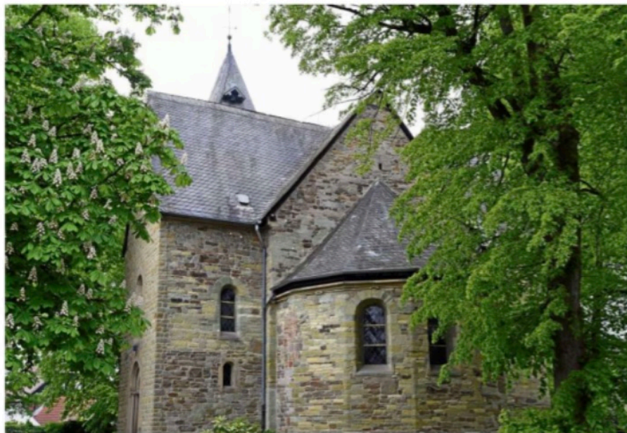
Die historische Johanneskirche in Hennen muss für viel Geld grundsaniert werden. Die Förderung in Höhe von 400.000 Euro vom Bund bringt die Gemeinde ein Stück näher ans Ziel.
